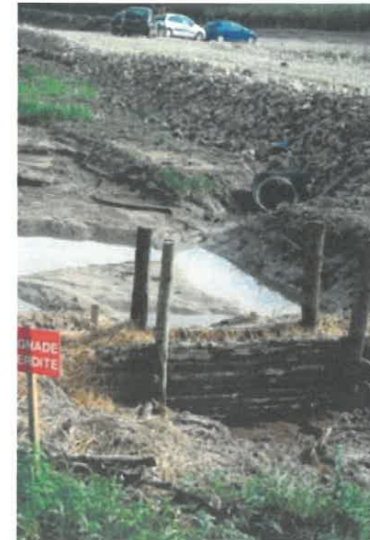
Figure 1 : Exemple de mise en place d'un filtre à paille
